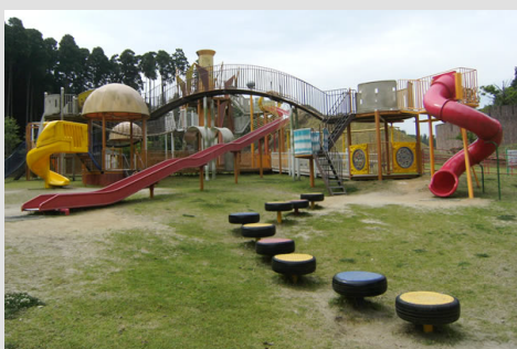
公園遊具設置
