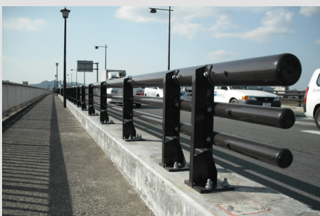
ガードパイプ
