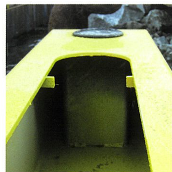
内部の角型スリーブ管
