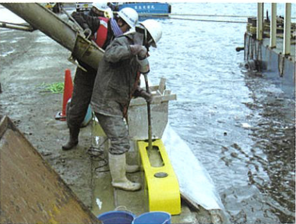
④充填口よりコンクリートを充填
