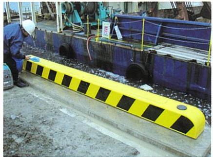
⑥コンクリートのろを清掃して施工完了
