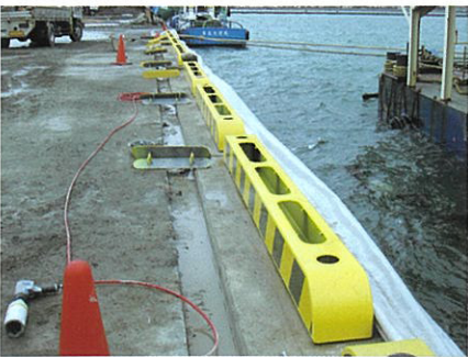
①車止め本体を設置
