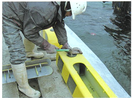
③固定孔に天端キャップを取付け
