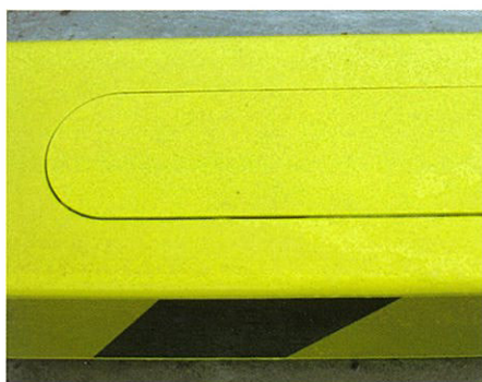
スベリ止め塗装（天端面）
