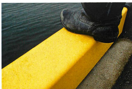
スベリ止め塗装(天端面) 足元の安全性を向上させます。
