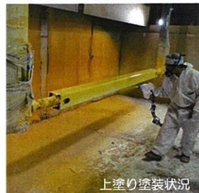
上塗り塗装状況
