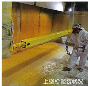
上塗り塗装状況
