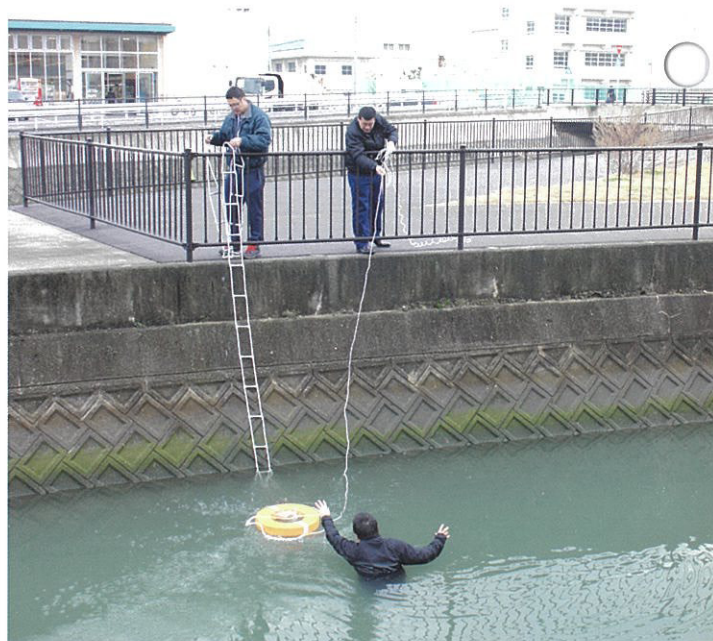
② 救命浮環を投下し、はしごをセットする。
