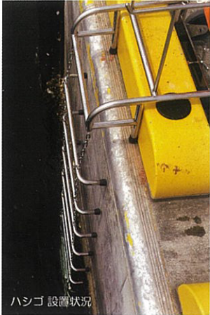
ハシゴ 設置状況
