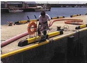
④ステップを投げ込みハシゴが完成
