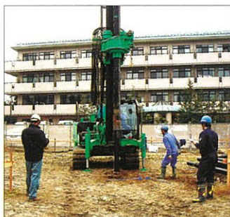
現場に赴き施工管理と安全性を確認
