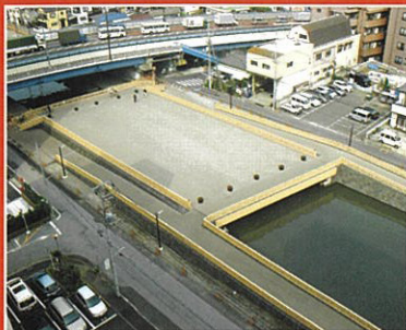
江戸川区新川広場橋(環7)架設工事(その1)
