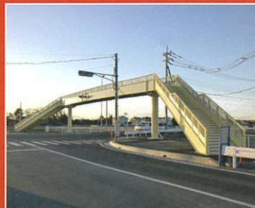
熊谷市自転車歩行者道整備工事
