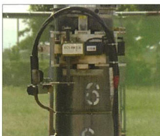
現場自動溶接ロボット工法ECS-AW
