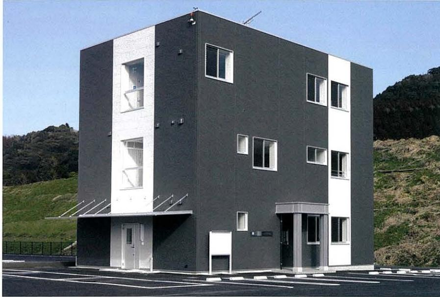
外周柱スパン2mピッチ設計が可能な「S-Grid」は、1間(1820mm)ピッチの当社従来品と比べ、設計プランの自由度が大幅にアップ。メーターモジュールで設計された在来工法のプランからの変更にも対応します。
