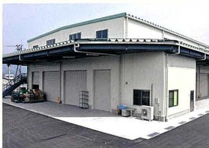
最大無柱スパン40m。(※2階建ては最大妻スパン15m)自由度の高い大空間を溶接軽量H形鋼を用いて実現しました。
