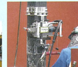
杭溶接 (ECS-AW 工法)
