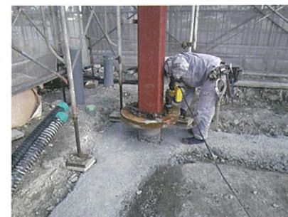
上部構造物とトッププレートを接合
