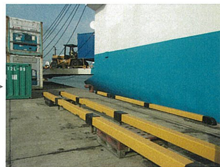
ランプウェイ稼働時の一時撤去状態
