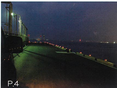
転落防止灯・岸線標示灯として
