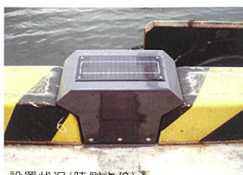
設置状況(陸側より)
