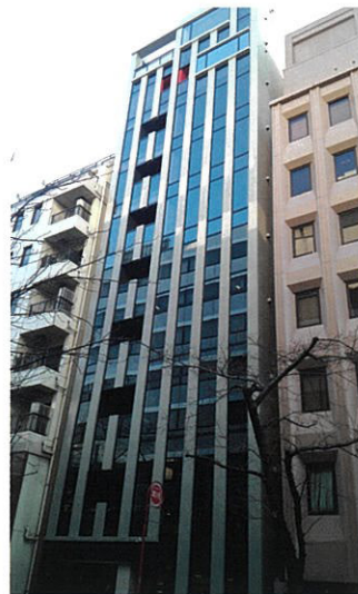
■ 中央区オフィスビル 【施工年月：平成 25 年 3 月】
