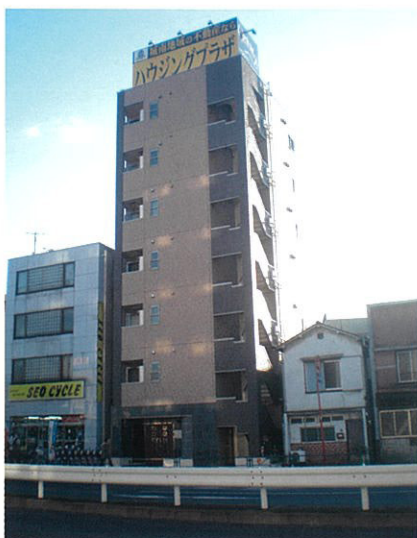
■ 大田区共同住宅 【施工年月：平成 18 年 8 月】
