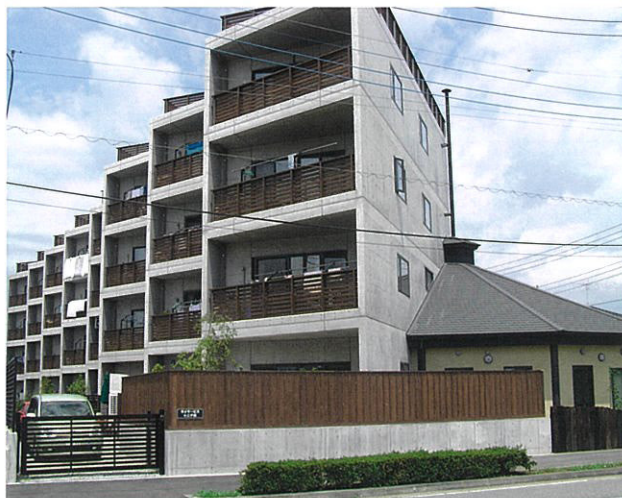
■竜ヶ崎市共同住宅 【施工年月：平成 19 年 1 月】
