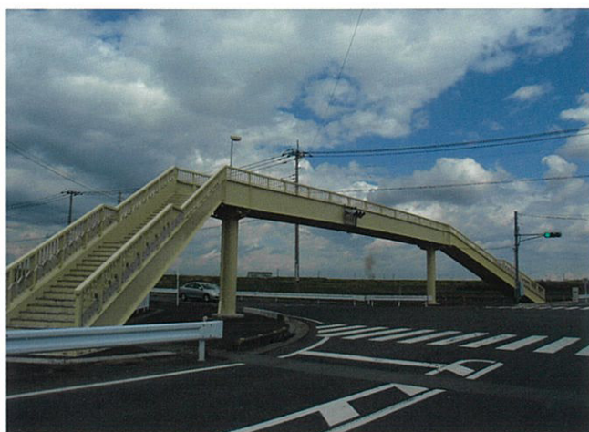
■熊谷市歩道橋 【施工年月：平成 24 年 7 月】
