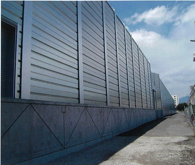
■群馬県某防音壁新設工事【施工年月：平成24年12月】
