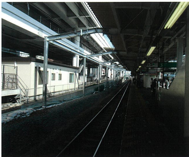
■ 日暮里駅拡張工事 【施工年月：平成 24 年 9 月】
