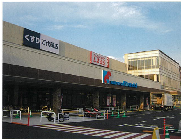
■西宮市商業施設 【施工年月：平成 23 年 11 月】
