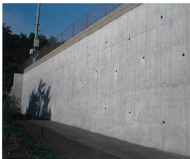
■所沢市擁壁 【施工年月：平成 18 年 1 月】
