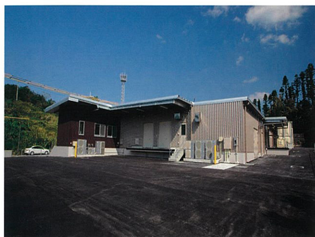
■沖縄県中頭郡某工場 【施工年月：平成 25 年 6 月】
