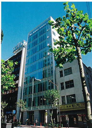
■ 中央区オフィスビル 【施工年月：平成 20 年 2 月】
