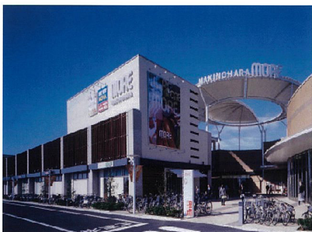
■印西市大型商業複合施設 【施工年月：平成 17 年 5 月】
