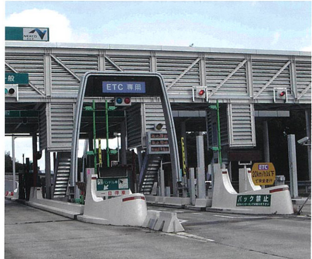
■大野インターチェンジ【施工年月：平成23年8月】
