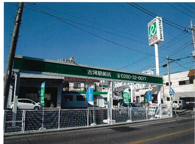
■古河市看板基礎【施工年月：平成 24 年 9 月】
