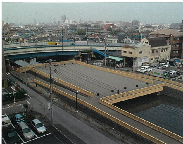
■江戸川区新川広場橋架設工事【施工年月：平成22年5月】
