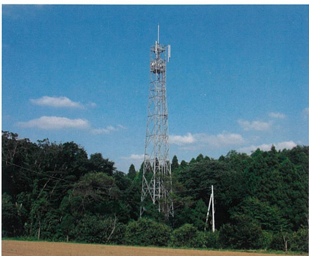
■四街道市通信鉄塔 【施工年月：平成 18 年 8 月】
