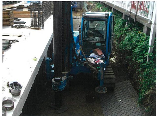
狭小施工現場例
