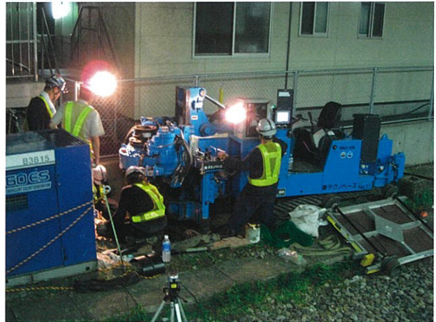
夜間施工（鉄道）
