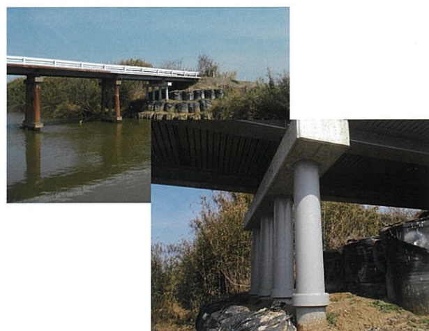
■登米市中島橋 【施工年月：平成 24 年 11 月】
