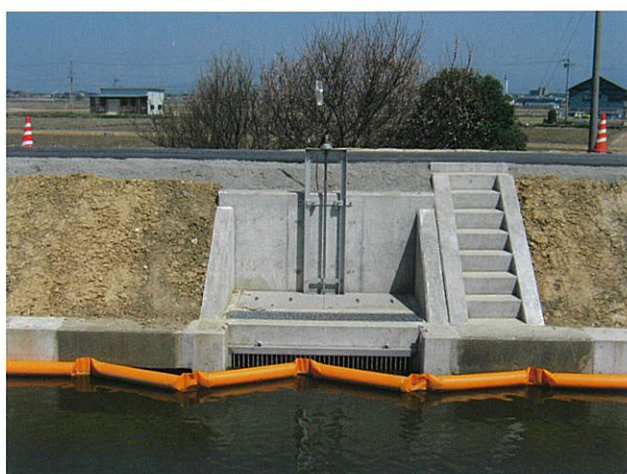
■米原市水門 【施工年月：平成 22 年 12 月】
