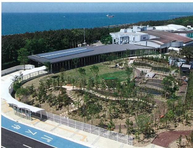
■新潟市水族館 【施工年月：平成 24 年 12 月】
