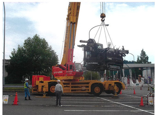
* 米原インターチェンジ
