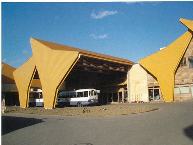
■千曲市養護学校 【施工年月：平成 18 年 5 月】
