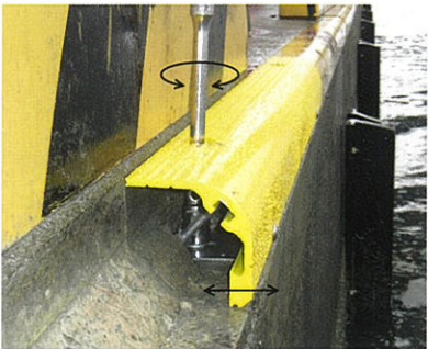
本体セット後、モルタル充填確認孔より 高さ・法線の微調整が可能です。
