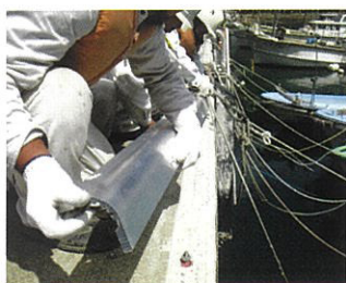
本体設置状況
