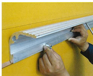
固定金具取付け状況(本体側)
