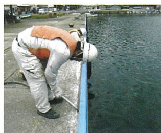
モルタル充填状況
