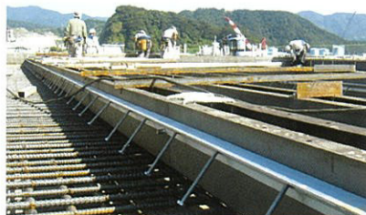
型枠設置状況
