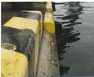
既設コーナー材撤去後
