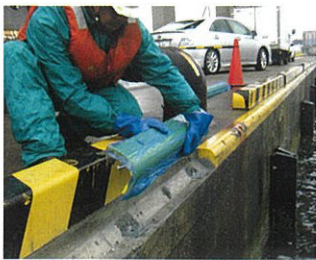
本体設置状況
