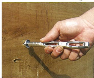
固定金具取付け状況(裏側)
