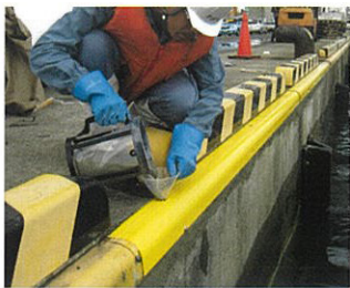
無収縮モルタル充填状況
