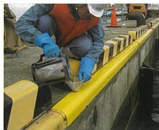
無収縮モルタル充填状況
