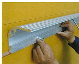
固定金具取付け状況(本体側)
