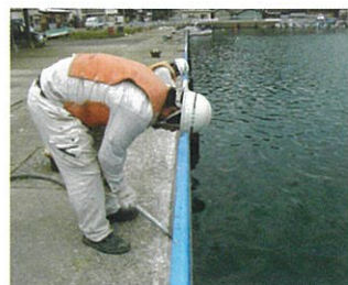
モルタル充填状況
