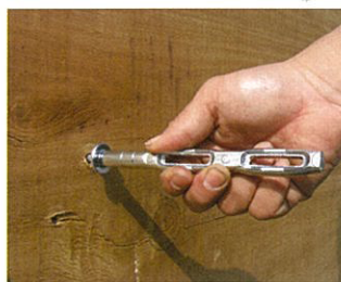
固定金具取付け状況(裏側)
