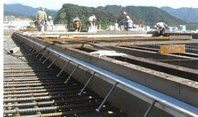
型枠設置状況
