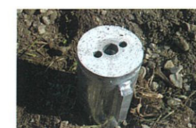
垂直方向 基準高さの+5.00mm、-10.0mm 以内で 施工します。
