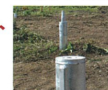
XY 方向 基準位置の±25mm以内で 施工します。
